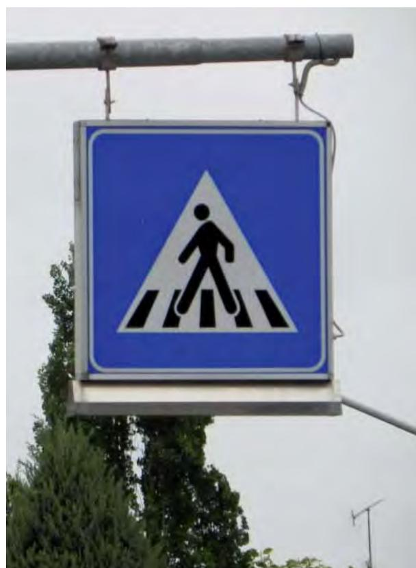
Segnale illuminato internamente e dotato di plafoniera per illuminare l'area interessata al passaggio di pedoni.
