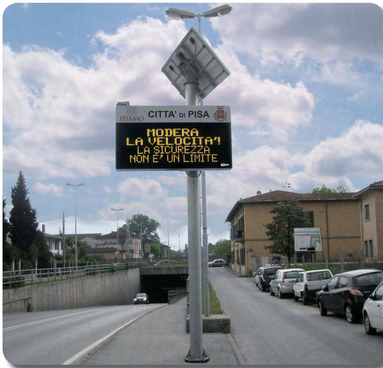
Innovativo display ad alimentazione fotovoltaica, caratterizzato dalla tecnologia LP (Low Power) idoneo a: realizzare un efficiente sistema di monitoraggio e controllo del traffico; visualizzare in tempo reale messaggi di grandi dimensioni; effettuare conteggio e classificazione dei veicoli in transito, della loro tipologia e velocità.
